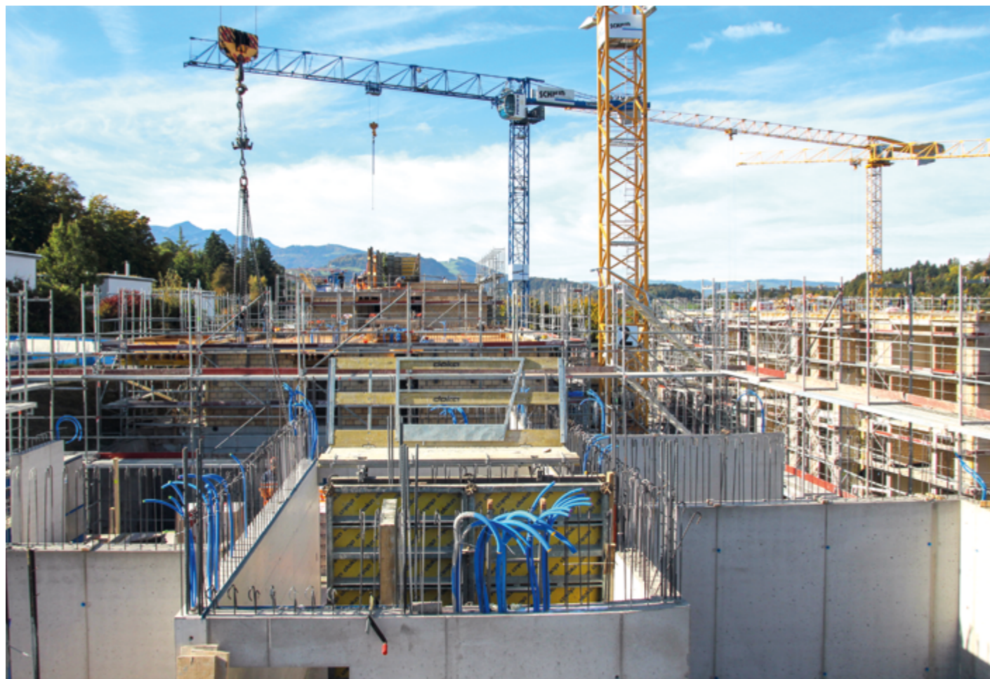
Pünktlich fertiggestellt: Alle vier Wochen wuchsen die acht Gebäude um eine Ebene höher.
