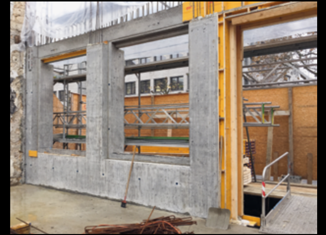
Die Aussenwände in Sichtbeton werden in einem Guss betoniert.
