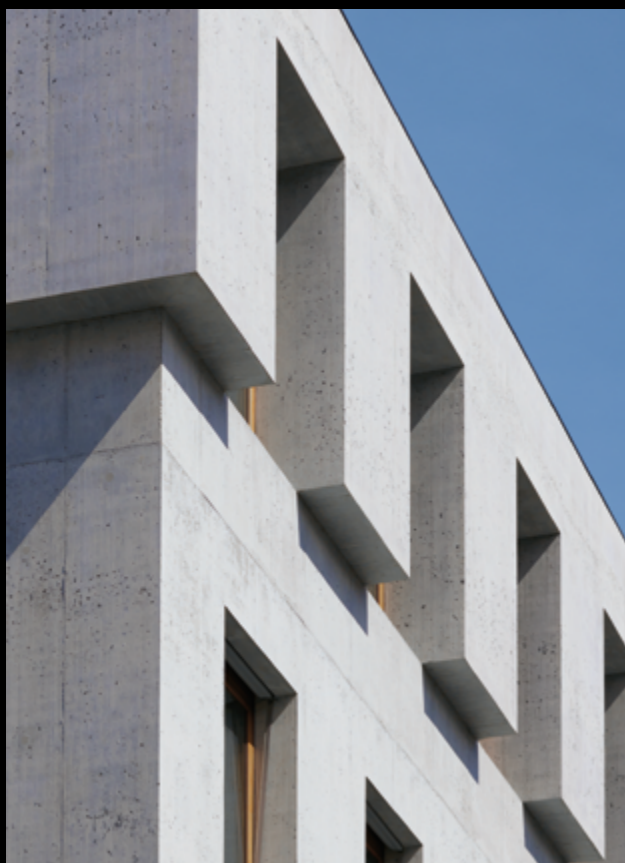
Herausforderungen mit vielen Fensteröffnungen, Absätzen und Verwinkelungen erfüllt.
