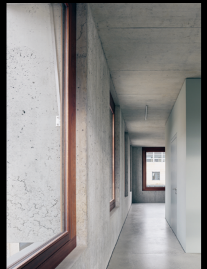
Aussenwände und einzelne Innenwände werden in Sichtbeton gehalten.
